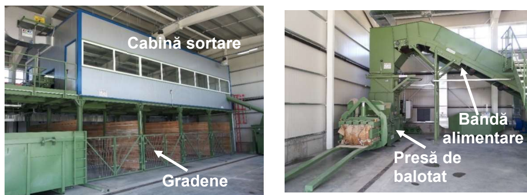
Figura 4.9. Imagini din Stația de sortare lanca
